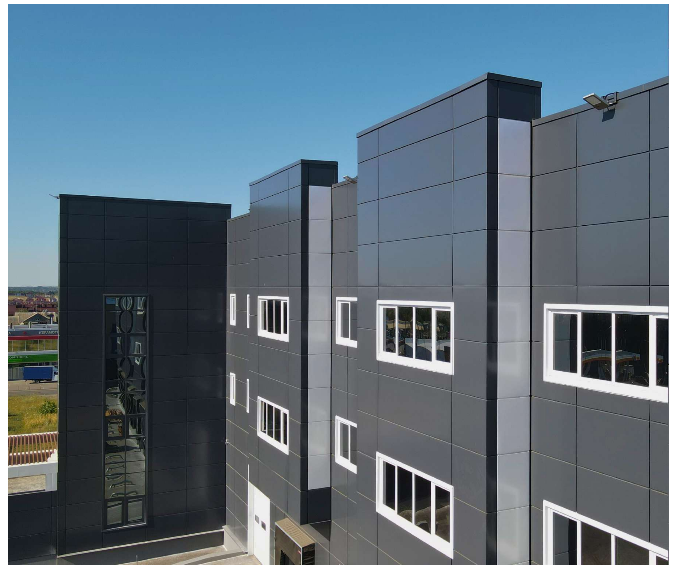
Bella административно хозяйственный комплекс, 2022г., Ростовская область, Аксайский район Горизонтальная система монтажа на металлокаркас.
